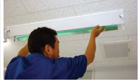
3. カサに貼り付けてください。(グロー管部及びネジ部は切抜いて下さい)
