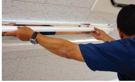
5. 蛍光灯を取り付け、設置完了。
